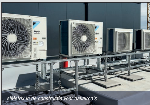
siMetrix direct aangesloten op de stalen drager
