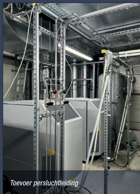
3-dimensionaal bevestigingsraster voor gebieden met een hoge installatiedichtheid en hoge eisen aan flexibiliteit.
