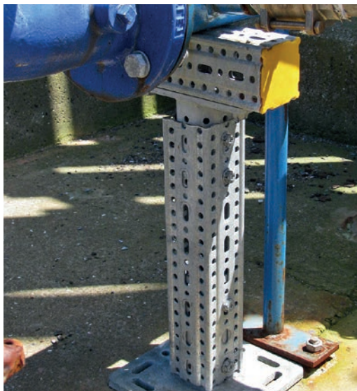
T-Supports conventioneel en siFramo 80 enkele maanden na montage
