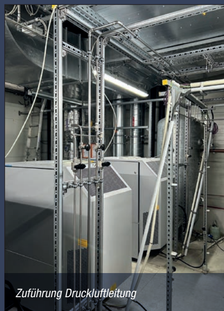
3-dimensionales Befestigungsraaster für Bereiche mit hoher Installationsdichte und hohen Anforderungen an die Flexibilität.
